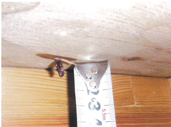
323 図中:㊦ 錆び汁が床合板にしみ込んでいる状態。
