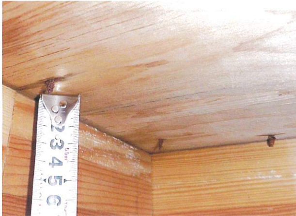
321 図中:㊦ 釘の錆が著しい (Y14、X1~X2)
