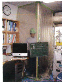
作業範囲を養生する
