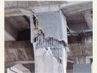
アラミドの被災事例
