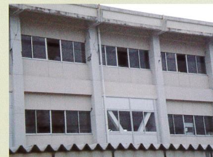
鉄骨ブレース補強校舎
